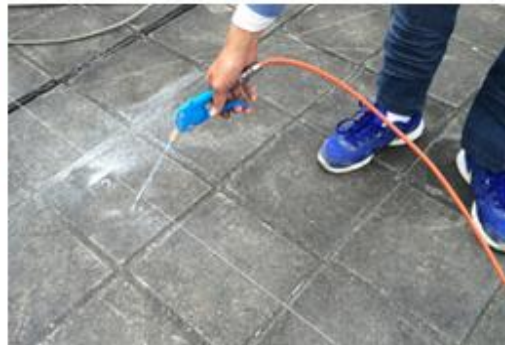
清除鑽孔內之異物
